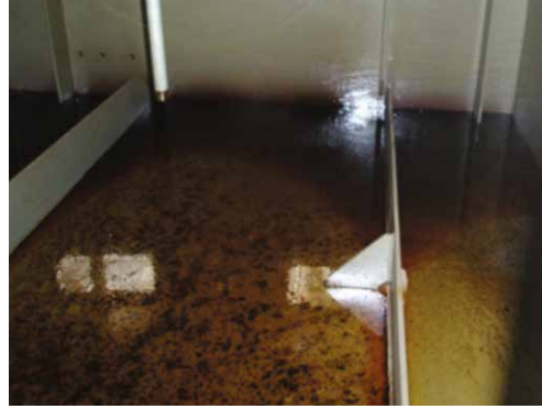
Gaz türbini yağ tankında, vernik yıkama işleminin ardından sistemden giderilen vernik ve tortu kalıntısı
